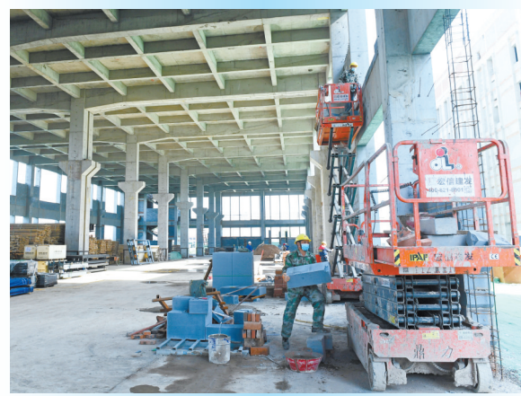
华为(山西·屯留)5G智慧产业园项目
